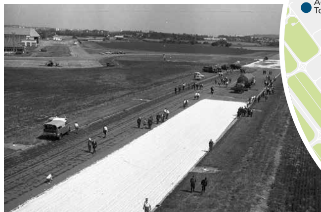
Ci-dessus : Construction de la seconde piste, en 22 juin 1967.
